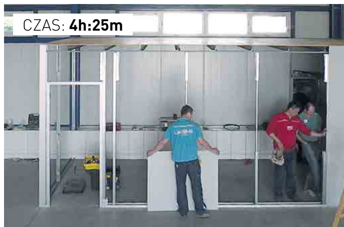
Montaż pełnych paneli
