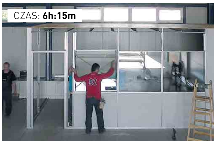
Montaż szklanych paneli
