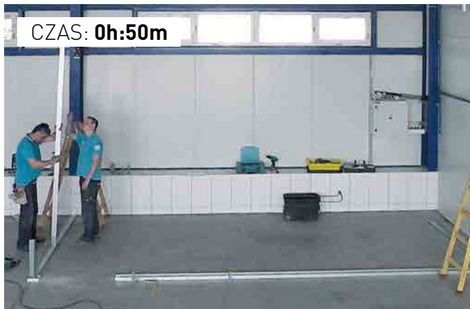
Montaż szkieletu konstrukcji
