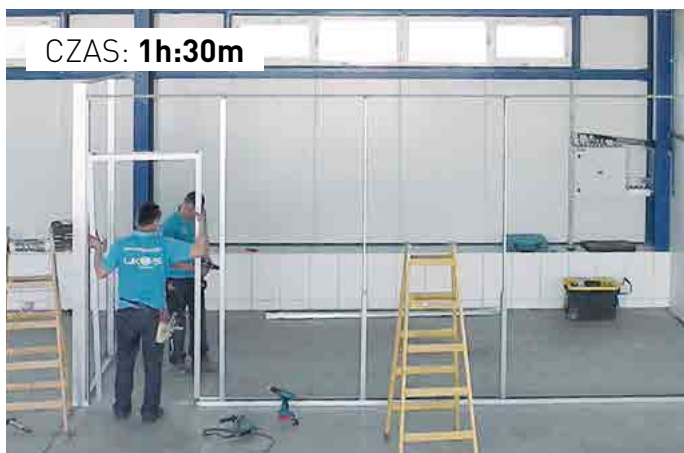
Montaż ościeżnicy drzwi
