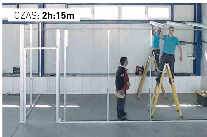
Montaż konstrukcji sufitu
