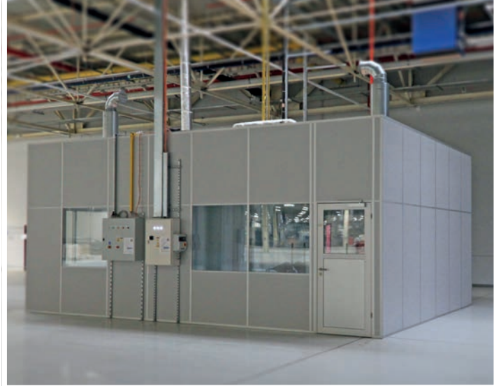
ZAMKNIĘTE POMIESZCZENIA NA HALACH
